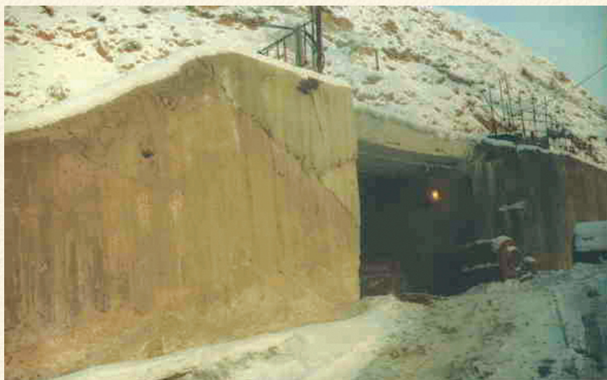
Рис. 1. Один из входов в штольню гипсового рудника «Олёкминского»
