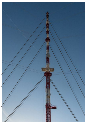
Рис. 30. Мачта переизлучателя с вантовыми растяжками, http://vk.com/wall-13502584_2023
