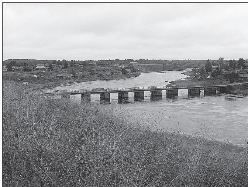
Мост через реку Нюхча. Вид с Николиной горы. Снимок 25 августа 2008 г. Мост на ряжах из бревен, заполненных внутри камнями и грунтом, возможно, впервые был сооружен в 1702 г. в связи с прокладкой трассы для «государева шествия».
