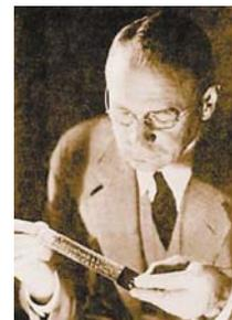
*Русский инженер, отец электронного телевидения В.К. Зворыкин (1889–1982) с разработанной им электронной телевизионной передающей трубкой – иконоскопом*
