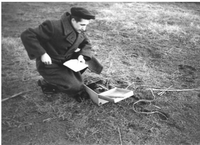
Аспирант П.И. Тугунов с помощью переносного потенциометра проводит измерение температурного поля грунта вокруг нефтепровода Озек-Суат-Грозный (1959)
