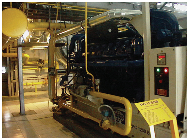
Рис. 28. Когенераційні установки фірми «МАДЕК»
