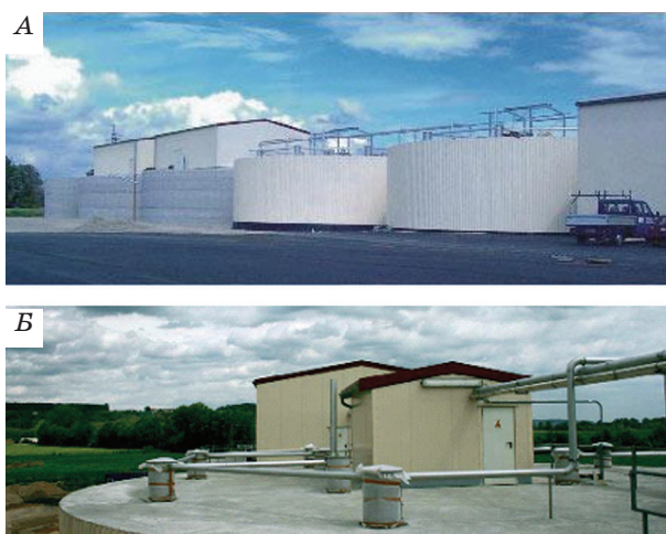
Рис. 11. Потужна біогазова установка фірми Zorg для цукрових заводів (А) і установка з перероблення пташиного посліду із заглибленим біореактором (Б)
