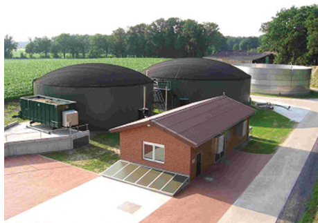
Рис. 8. Загальний вигляд установки Zorg
