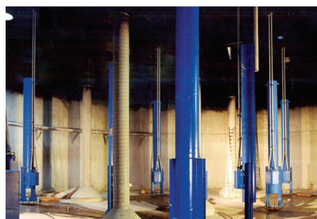
Рис. 19. Перемішувальні пристрої Cannon®Mixer усередині ферментера
