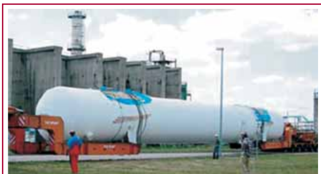
Рис. 8. Стационарный резервуар РЦГВ-250/0,25 транспортируется к месту его установки
