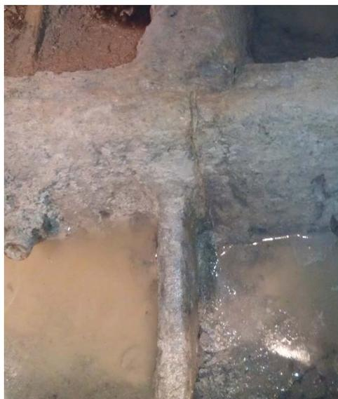
*Рис. 8. Фактическая трещина в лотке обделки*
