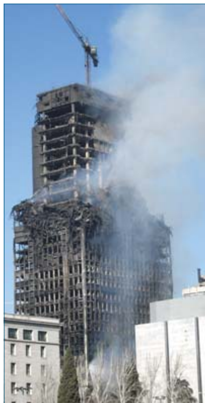
Рис. 2. Последствия пожара в небоскребе “Виндзор” 13 февраля 2005 г. в Мадриде (Испания)
