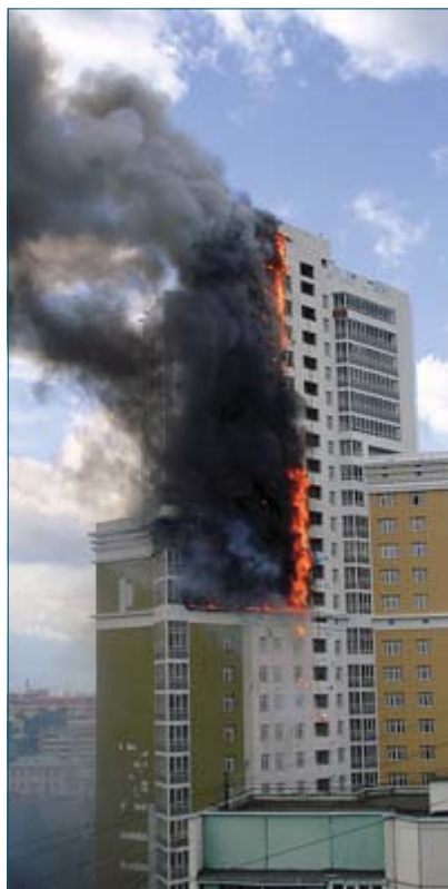
Рис. 3. Пожар в 27-этажном здании в Москве в августе 2009 г.
