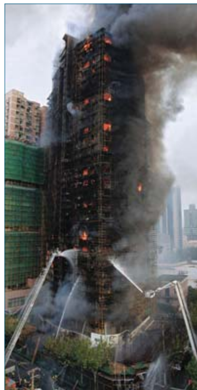
Рис. 4. Пожар в строящемся здании в Шанхае (Китай)
