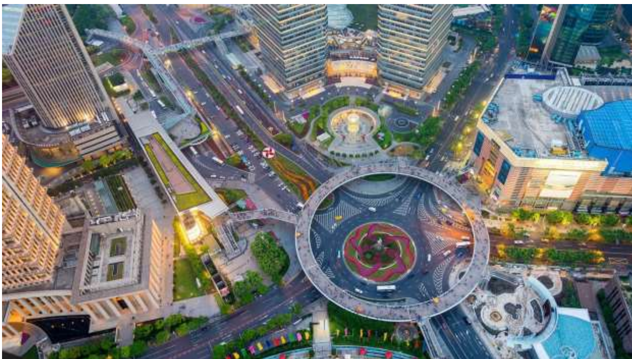
Рис. 7. Пешеходный переход в Шанхае (имеющий подъёмы с эскалаторами).
