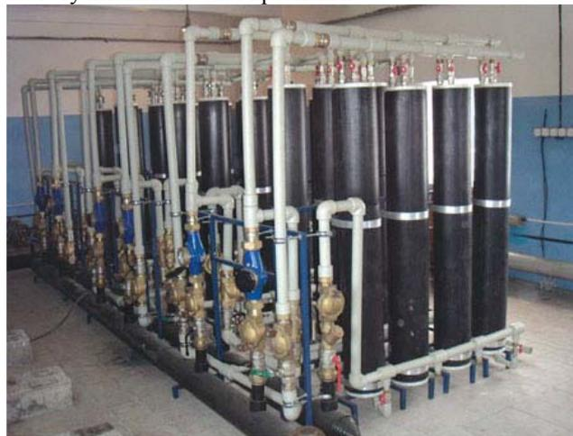
Рис. 4. Внешний вид станции. Мембранные блоки, общая подача – 100 м<sup>3</sup>/ч
