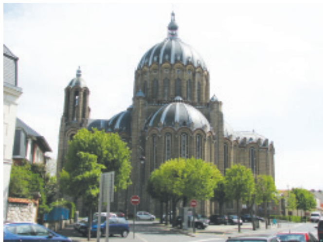
А. Госсэ. Церковь Св. Клотильды. Реймс. 1898–1905
