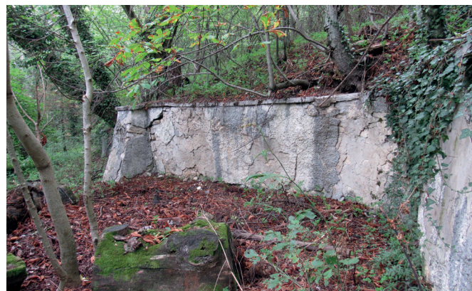
Рис. 12. Подпорная стена в Эриклике. Фото И.Н. Слюньковой. 2018 год
