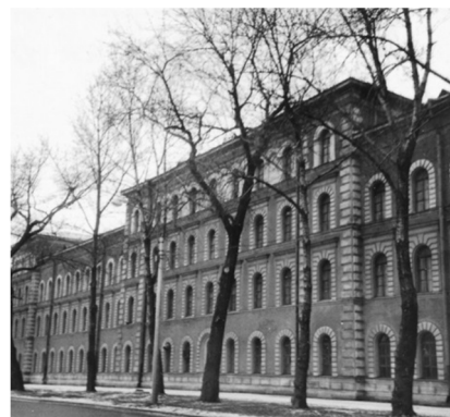
Фасад Черноморского корпуса казарм Л.-гв. Казачьего и Л.-гв. Атаманского полков (1846–1852) и ц. Св. Иерофея, епископа Афинского, на набережной Обводного канала. Фото 1980-х гг.
