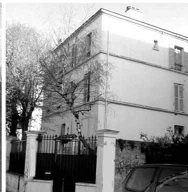
Аньер-сюр-Сен. Здание, в котором размещается храм Христа Спасителя. Современный вид. Фото с сайта http://www.russie.net/Hram-Hrista-Spasitelya-An-er-syur-Sen
