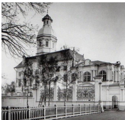
Церковь Благовещения Пресвятой Богородицы и Св. Благоверного кн. Александра Невского Александро-Невской лавры. Фрагмент фото мастерской К. Буллы, конец XIX – начало XX вв.
