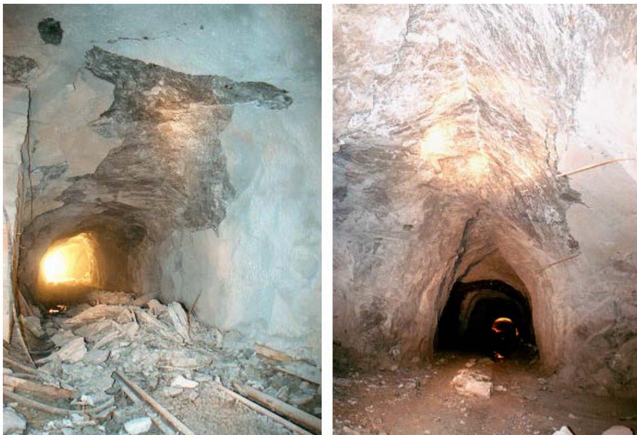
*Рис. 2. Разрушение выработок под действие высоких напряжений в массиве ГП*
